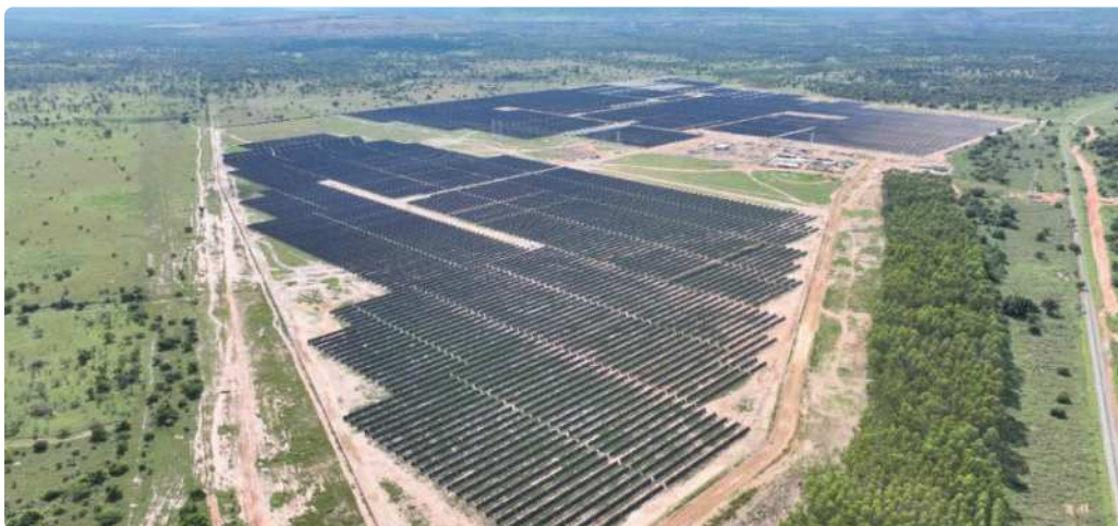
Planta solar fotovoltaica Drummond Ltd.
