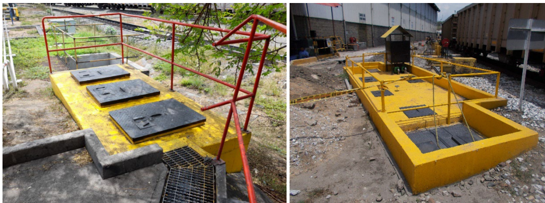
Fotografía 3-3 Estructura de Control de Derrames Internos
